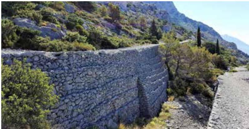
Fotografija u boji ceste na Biokovu iznad Brela i Makarske, podzid sa stepenastim vanjskim licem i ojačanjem. Privatna fototeka Josip Belamarić, br. 14A
